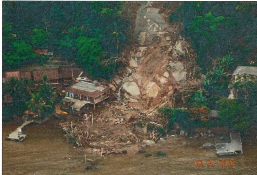
Figura 3.1-28: Escorregamento translacional atinge a Pousada Sankay, localizada na Enseada do Bananal em Ilha Grande. O evento ocorreu na noite de réveillon. Fonte: Ribeiro (2014).
